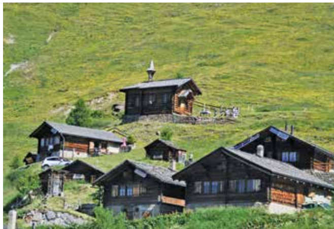
Vue sur l'alpage de Torrent et sa chapelle. Photo: Désirée Varonier
